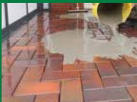
Spezialfuge SF anrühren und die Fugmasse auf vorgegebener Fläche verteilen
